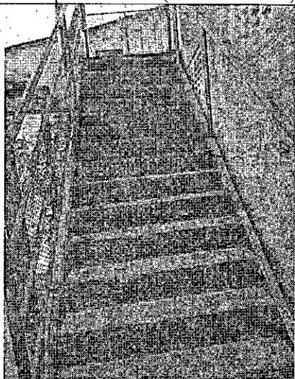
Imagem 05 – escada Fonte: Arquivo Pessoal (dezembro 2020)
