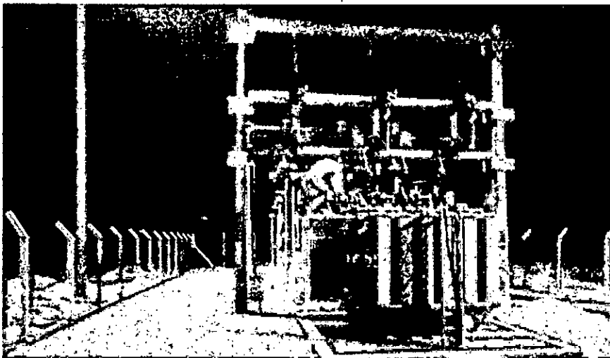
FOTO NOTURNA DA SUBESTAÇÃO 69KV – DETALHE DO TRANSFORMADOR
